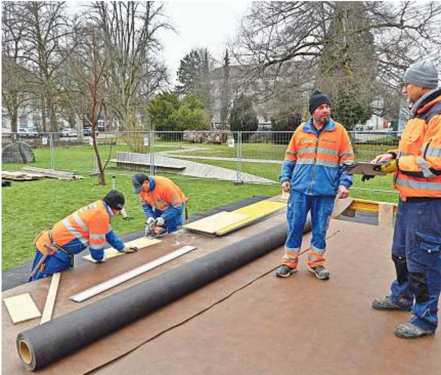
Bei trockenen Wetterverhältnissen wird ein erster Teil der Bühne für das Freilichttheater im Rosengarten Zofingen errichtet. BILD: NICOLAS RUSSI
